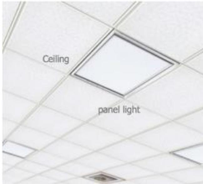
**Eingebettet II.** Die Installationsumgebung erfordert, dass der Sicherungsring eingebettet ist und ein Loch in die Decke gebohrt wird. Die Größe des Lochs ist kleiner als die Größe der Leuchte, und dann wird das Licht an der Decke durch die elastische Kraft der Feder absorbiert.
